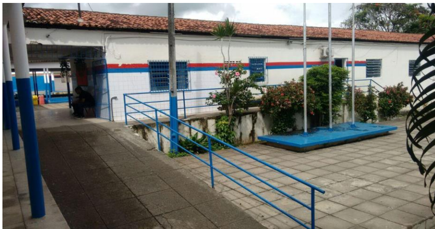
Figura 4: Rampa de acesso
