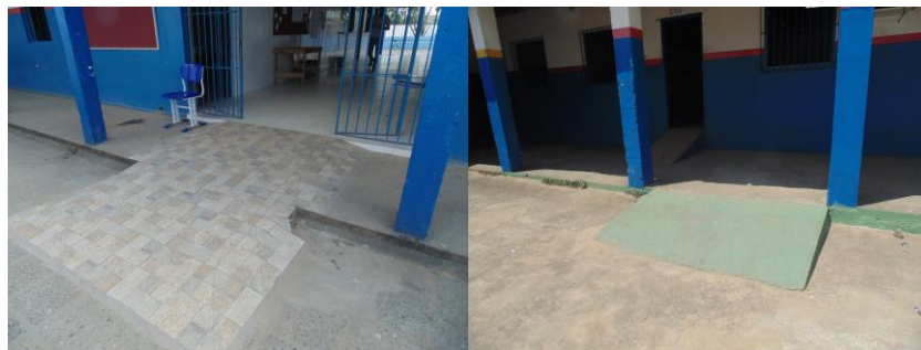
Imagem 3 - Rampas de acesso existentes na escola
