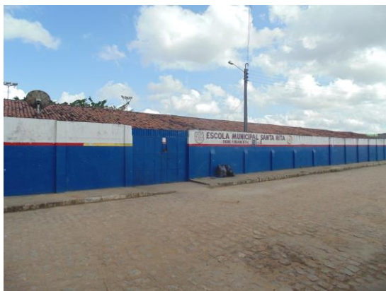
Imagem 1 - Fachada da escola Santa Rita
